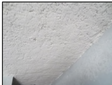
Photo N° 610 ECH-N°2 FLOCAGE -- LOCAL VELO Plafonds Blanc cotonneux
